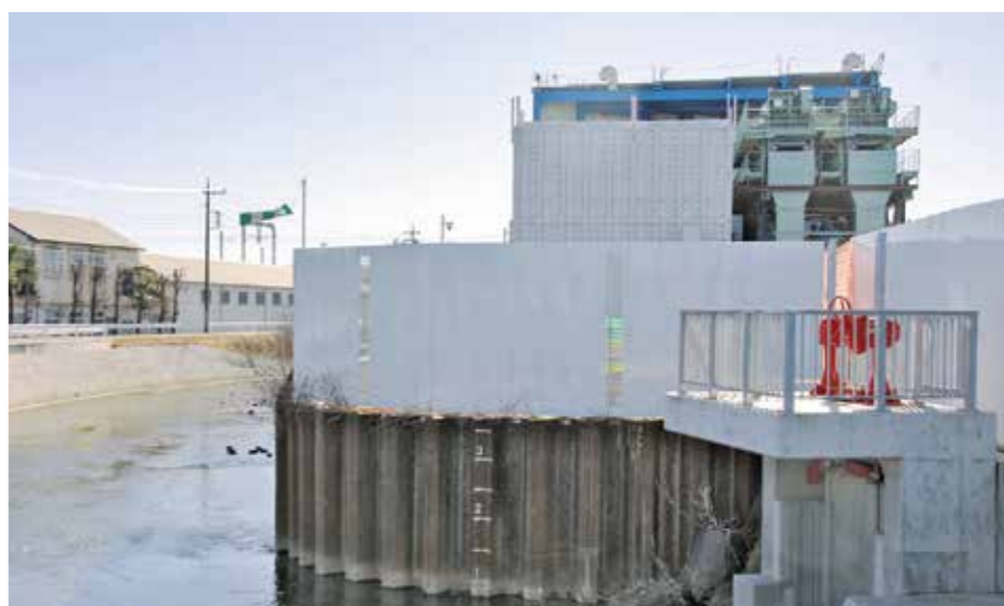
工事が進行する流出施設（沼和田町）
