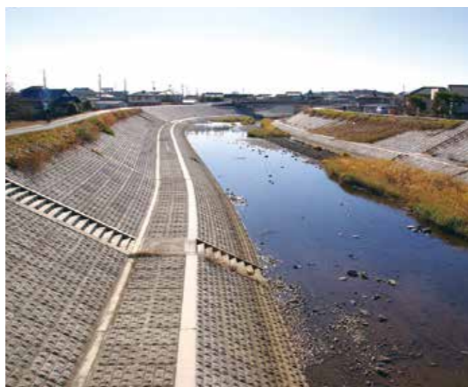
復旧工事後の永野川の風景
