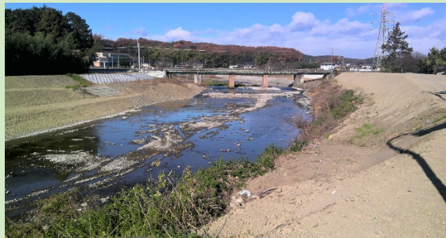
両毛線架橋付近の改修工事の様子
